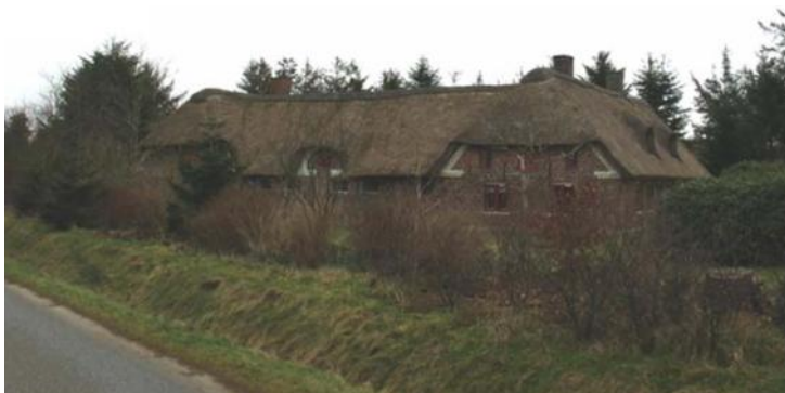
Beboelsesbygningens vestside set fra Hennebysvej
