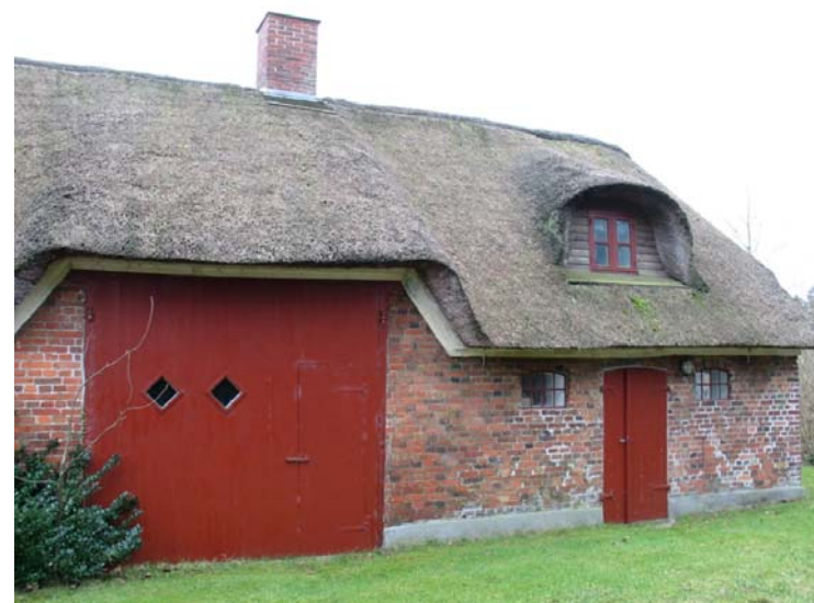
Nordsiden af beboelsesbygningen, hvor der påtænkes etableret udeservering og indgang til caféen gennem porten til venstre.
